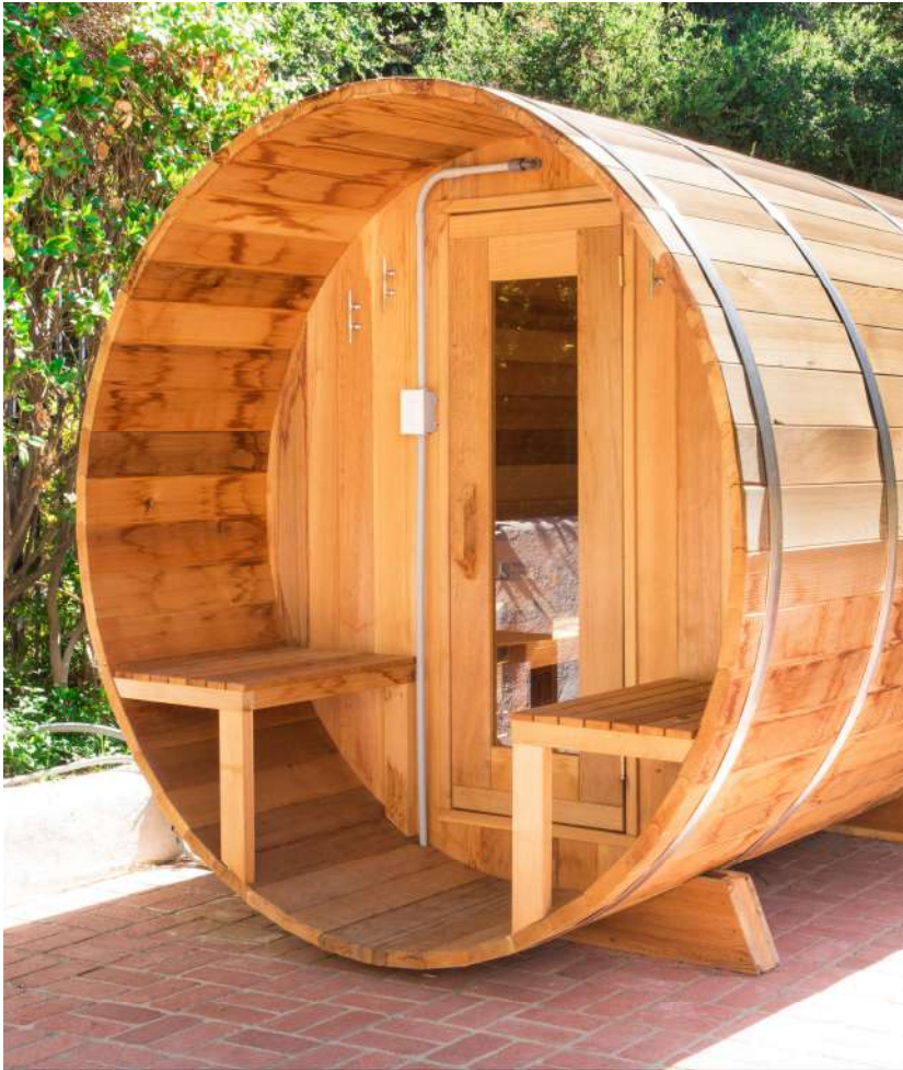
Weatherproof Conduit & Light Switch
